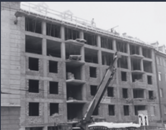
Umbau Hotel Innsbruck
