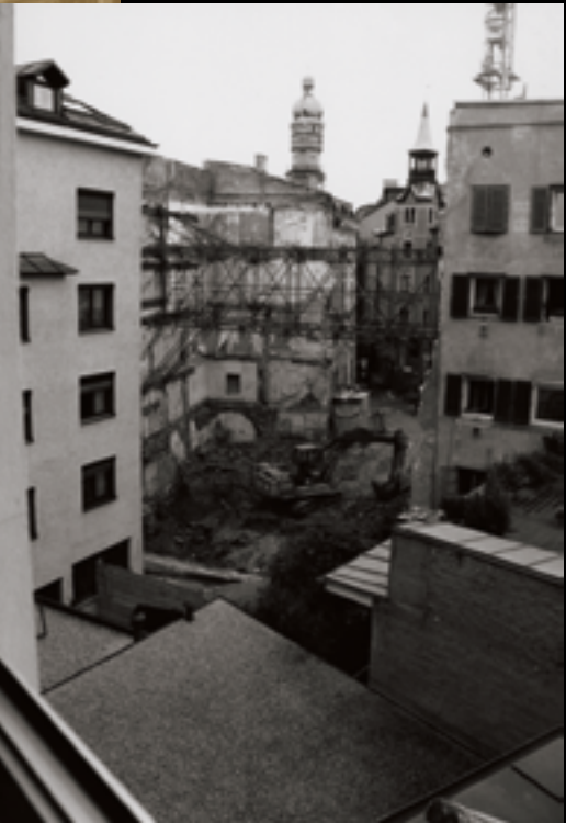
Köhlehaus nach Abriss
