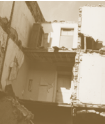
Das alte Gebäude wird schließlich von Hand abgetragen.
